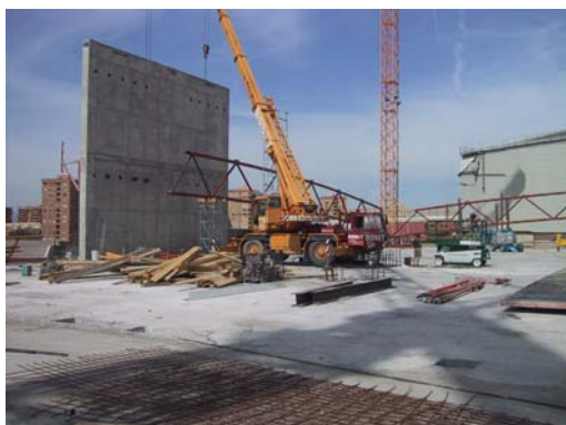
Figura 17: Cargas provisionales sobre el forjado mixto
