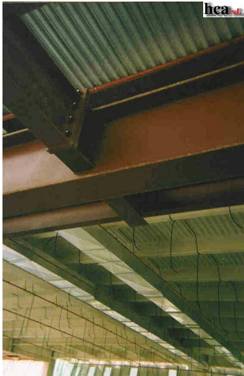
Foto nº 5. 4: Protección "gunitada", parcialmente ejecutada.
