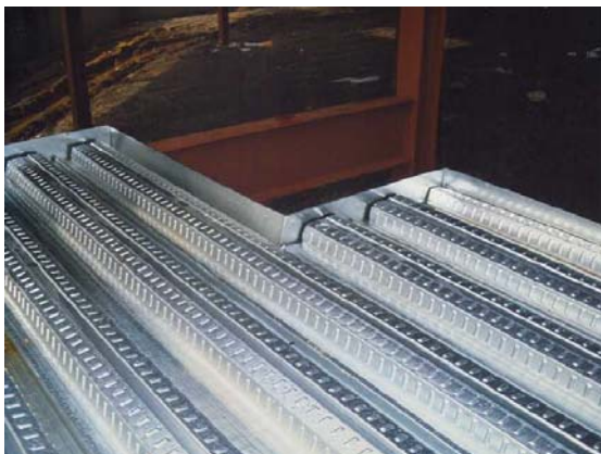
Foto nº 3.12: Perfiles metálicos utilizados para remate perimetral
