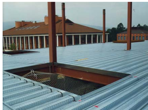
Foto nº 3.12: Perfiles metálicos utilizados para remate perimetral
