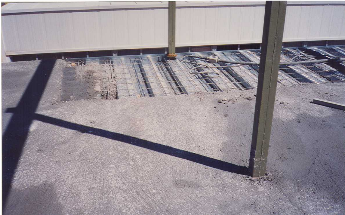
Foto nº 3.11: Fase de hormigonado
