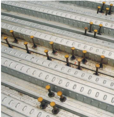
Foto nº 3.9: Colocación de conectores.
