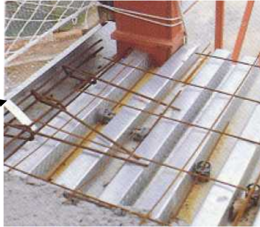
Foto nº 3.13: Modo de disposición de tirante de contención
