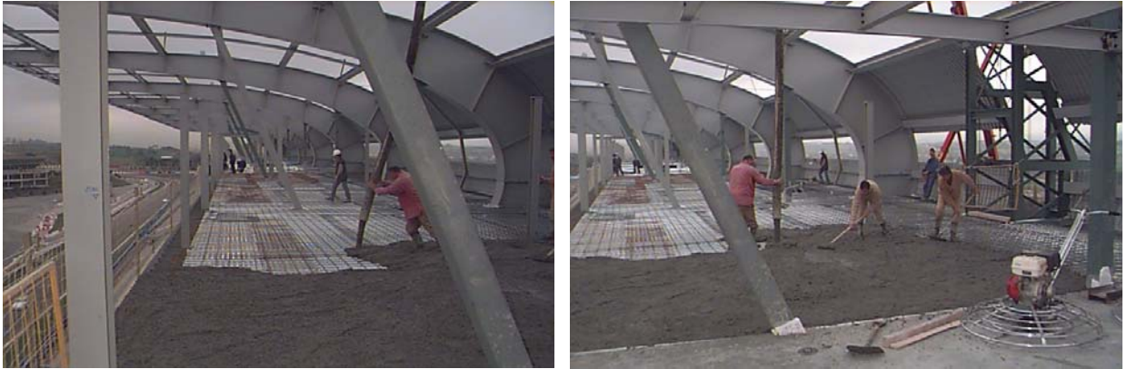
Foto nº 4.5: Hormigonado por bombeo
