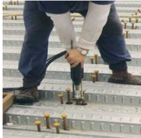
Foto nº 3.9: Colocación de conectores.
