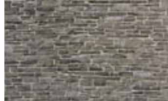
Ref. pared ladrillos de primer laboratorio
