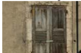
Ref. ventanas edificios-cubo
